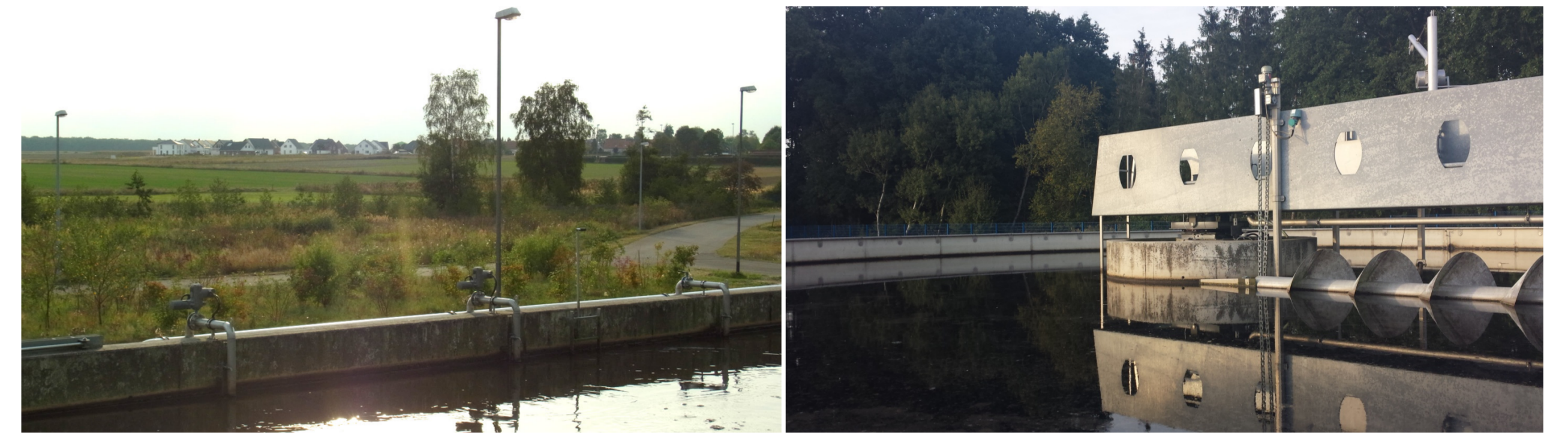
Abbildung 2: Belebungsbecken (links) und Nachklärbecken (rechts) der Kläranlage Wolfsburg-Hattorf (Fotos: ISOE und ISWW)
